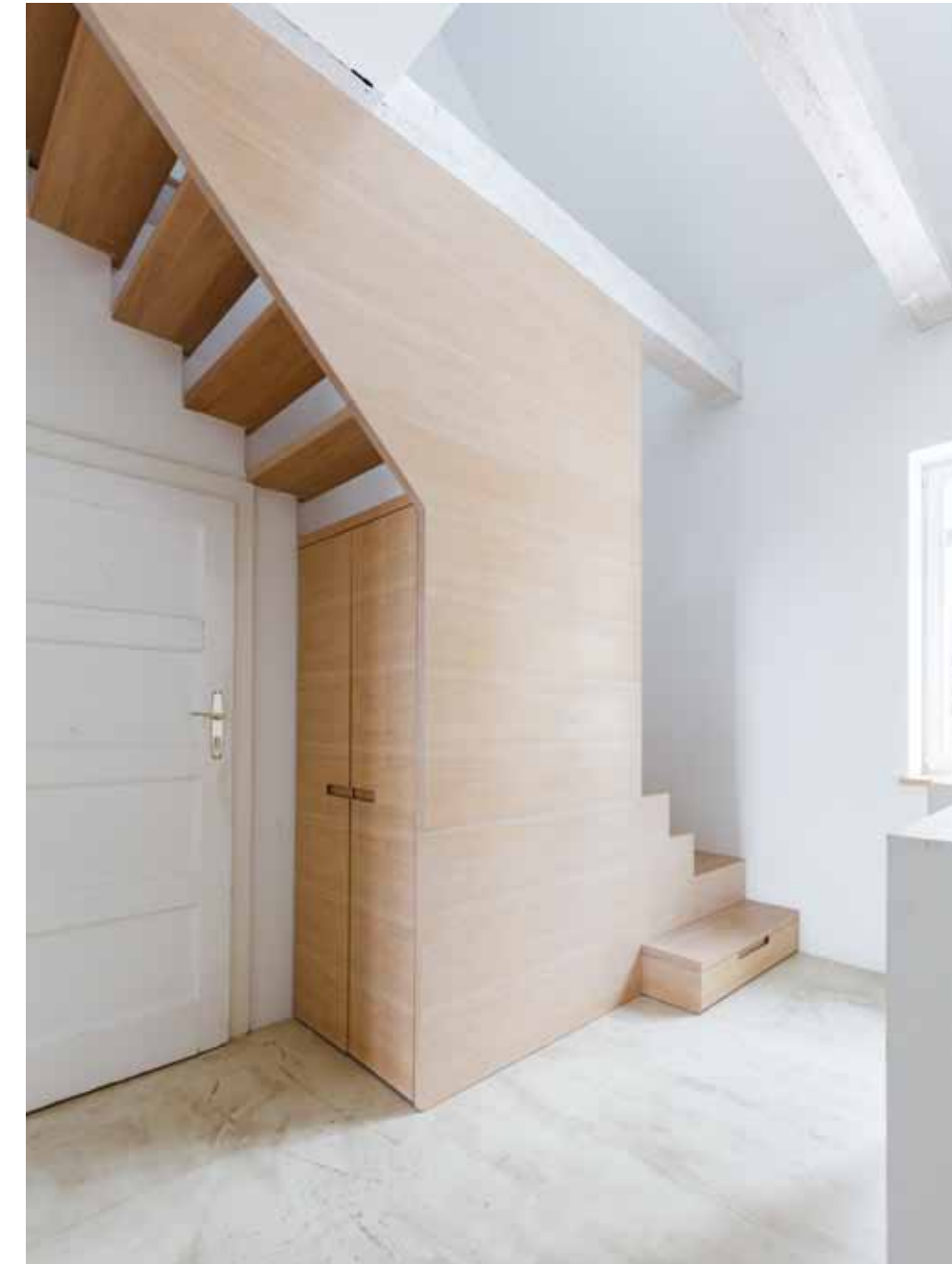
Raumskulptur: Die Treppe aus Eichenholz dient zugleich auch als Stauraum.
