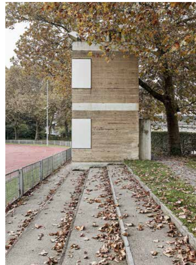
2001–2002: Gerätehäuser und Zielturm für die Sport- und Freizeitanlage Sihlhölzli in Zürich.
