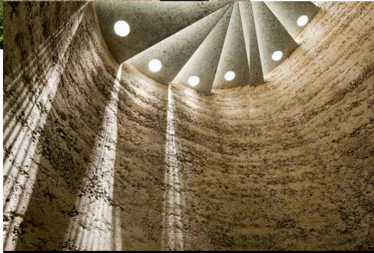
2004–2008: Haus Rauch in Vorarlberg ist nicht nur ein Wohn- und Arbeitsort, sondern auch ein Musterhaus, an dem experimentelle Anwendungen des Materials Lehm erforscht wurden.
