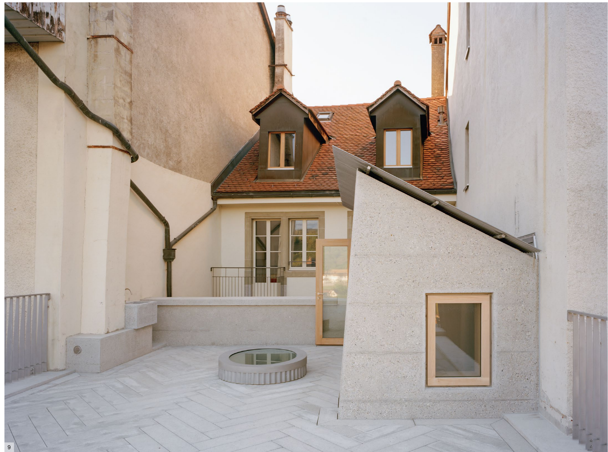
9 Fließend auf der Dachterrasse nehmen die vorgefertigten Fliesen das Fischgrätmuster des alten Parketts auf.
